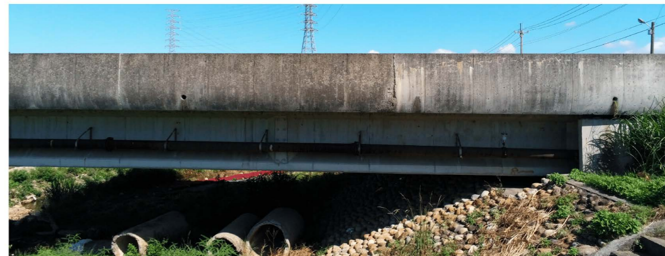
Мост Ай-Хе, расположенный в районе Янмей города Таюань, Тайвань
